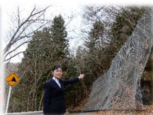
防護ネット設置 生活道路の安全確保 利根町穴原林道
