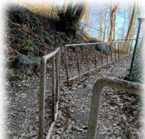
通学路の安全確保 利南東小学校通学路
